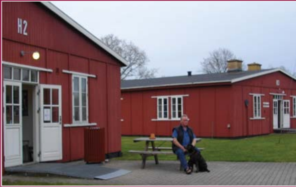
Hjemmeværnsmuseets hovedindgang i Barak H 2. Til højre ses Barak H 3
